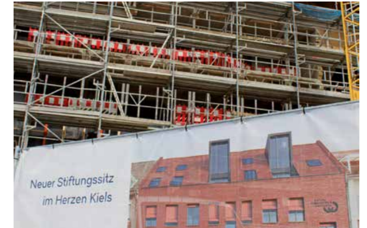
Baufortschritte am Wall 40
